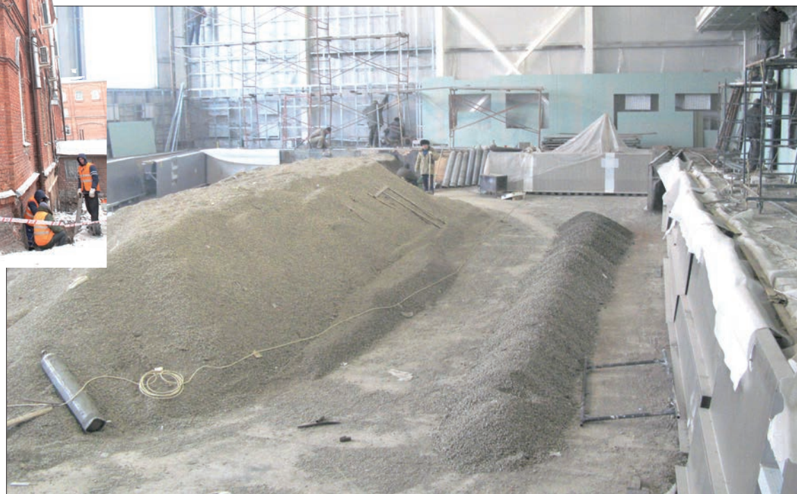
Пока внутри вместо воды сыпучие стройматериалы.
